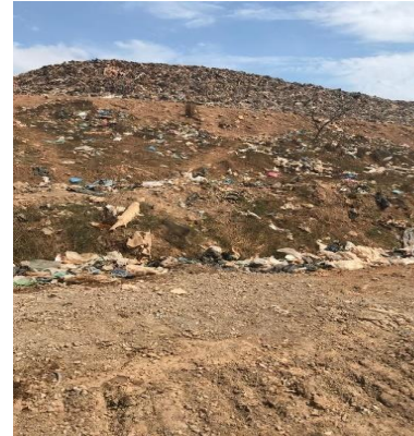
TALUD O BARRERA DE RESIDUOS SOLIDOS
